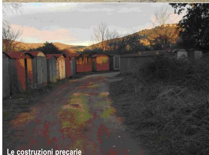
Il degrado presente nell'area
